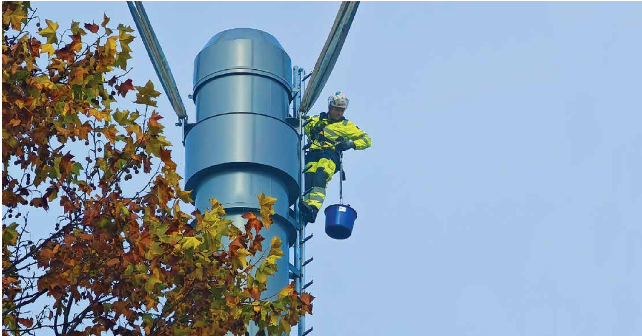
Dimnik v kotlovnici na lesno biomaso Foto: JHMB
