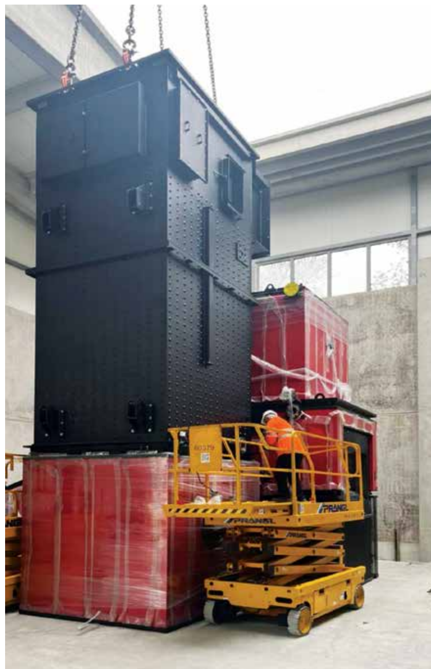
Vnos in sestavljanje elementov lesno biomasne kotlovnice Foto: JHMB
